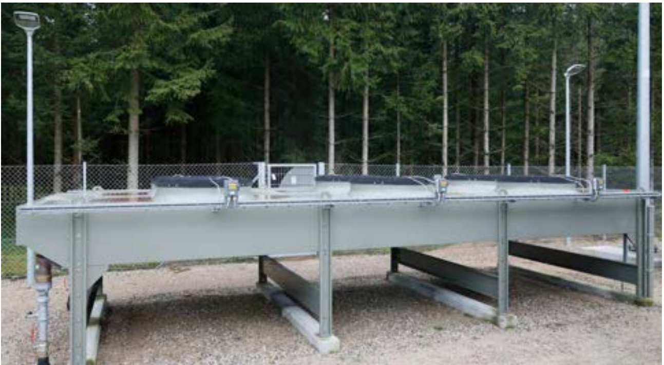
Foto nr. 02. Køler til kompressorer.
